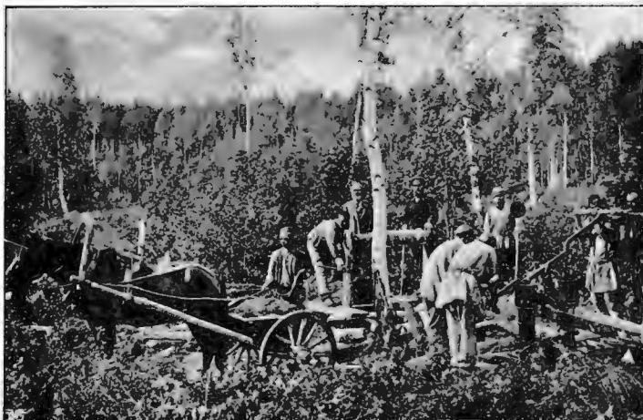
Пробивка шурфа на платиновомъ приискѣ на Уралѣ. (Perement d'un ereux dans une mine de platine sur l'Oural).
